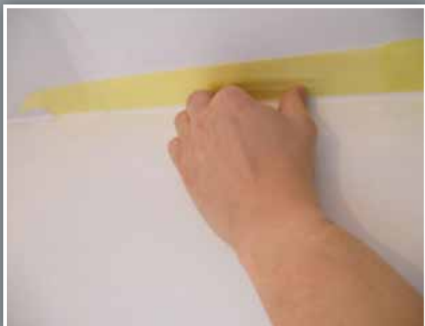
1 AFPLAKKEN VOOR HET AANBRENGEN VAN DE PRIMER
