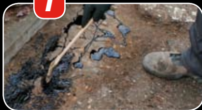
Primer aanbrengen
